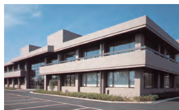
1988年竣工のイオン線形加速器実験棟
