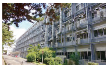
2010年 研究所本館耐震改修工事完了
