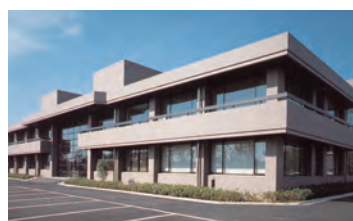
1988年竣工のイオン線形加速器実験棟
