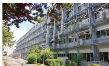
2010年 研究所本館耐震改修工事完了
