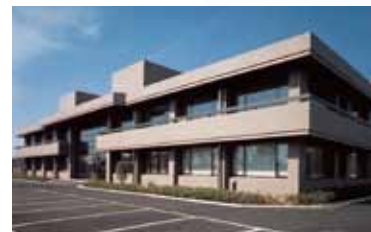
1988年竣工のイオン線形加速器実験棟
