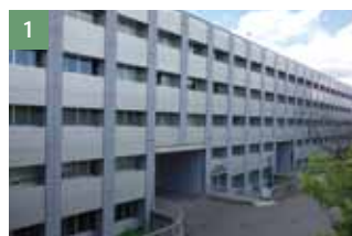
1 化研本館 13,470m 2 附属図書館宇治分館 (N棟 1階) 化学研究所担当事務室 (E棟増築棟 3階)
