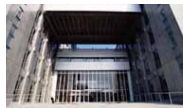
2004年竣工の総合研究実験棟
