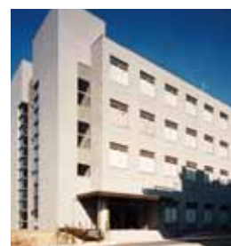
1999年竣工の 共同研究棟
