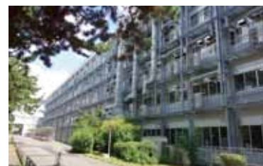
2010年 研究所本館耐震改修工事完了
