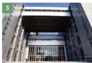
3 総合研究実験棟 11,199m 2 バイオインフォマティクスセンター
