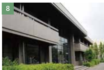
8 イオン線形加速器棟 2,668 m 2 先端ビームナノ科学センター
