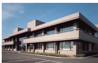
イオン線形加速器実験棟の竣工
