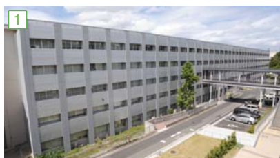
1 本館 11,714 m 2 附属図書館宇治分館(N棟1階) 化学研究所担当事務室(E棟増築棟3階)
