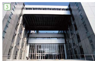
3 総合研究実験棟 11,199 m 2 バイオインフォマティクスセンター
