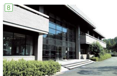
8 イオン線形加速器棟 2,910m 2 先端ビームナノ科学センター
