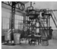
1939年頃、喜多研究室にて研究されていたガソリン合成試験装置の一部（化学研究所講演集第九号より）
