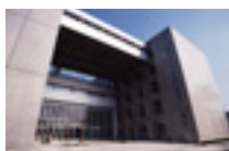
2004年竣工の 総合研究実験棟
