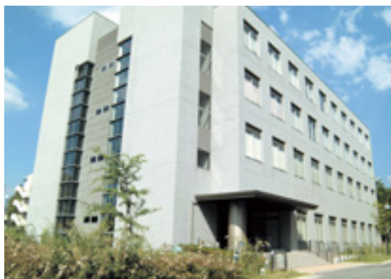
■ 共同研究棟 3,777m 2 ■ 附属図書館宇治分館(1階)
