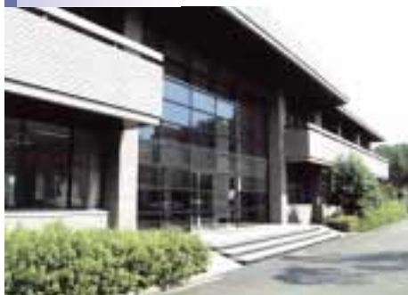
イオン線形加速器棟 2,910m 2 (先端ビームナノ科学センター)
