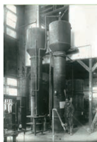
ポリエチレン工場のアルバムより液化エチレン精留塔の写真
