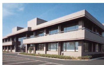
1988年竣工のイオン線形加速器実験棟
