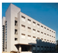
1999年竣工の 共同研究棟
