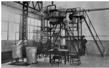
1939年頃、喜多研究室にて研究されていたガソリン合成試験装置の一部
