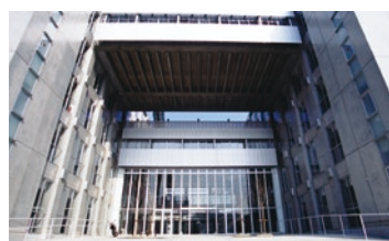
2004年竣工の総合研究実験棟
