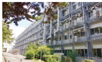
2010年 研究所本館耐震改修工事完了
