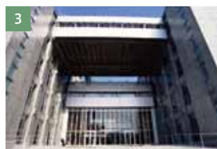
3 総合研究実験1号棟 11,199m 2 バイオインフォマティクスセンター
